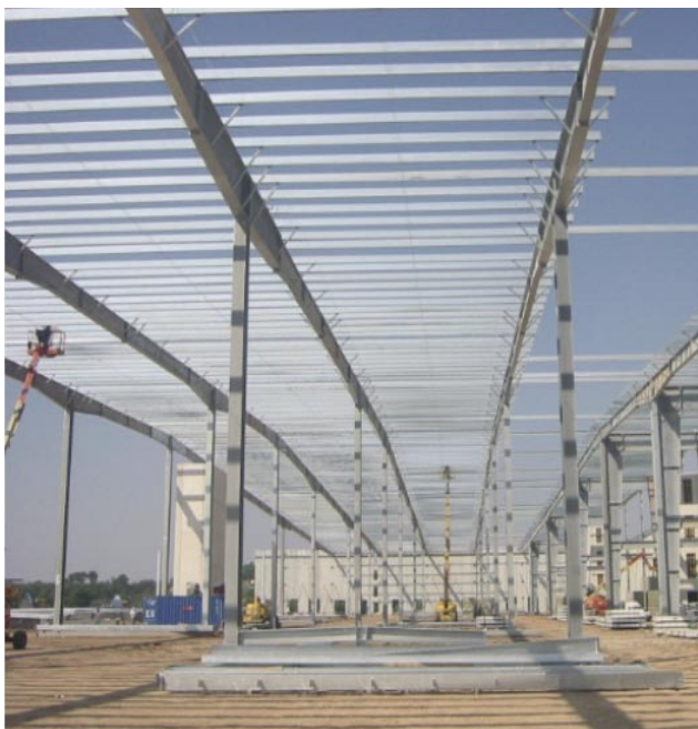
-Muntatge de xarxes de seguretat amb mitjans auxiliars d'elevació mòbils.
