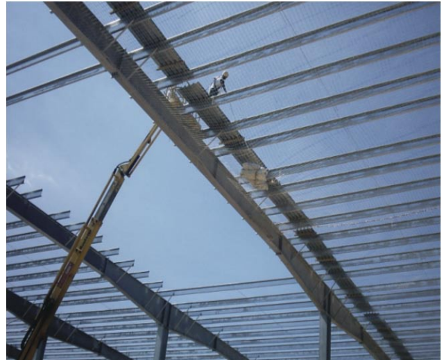
-Prova de càrrega d'una xarxa de seguretat.
