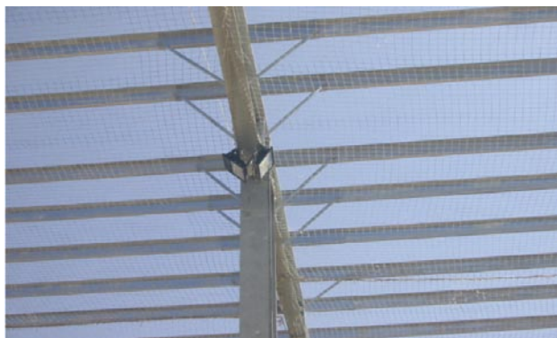
-Xarxes de seguretat en coberta de nau metàl·lica.
